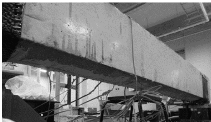
図 1.5.18 BFRP ロッドの緊張接着の状況
