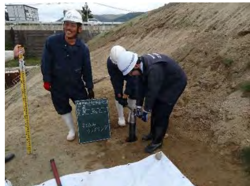
図 4.3.41 サンプラーの抜き出し(方法 B)
