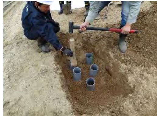
図 4.3.37 塩ビ管の打ち込み (方法 A)
