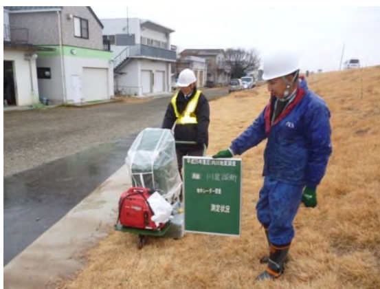
図 4.3.82 地中レーダー探査
