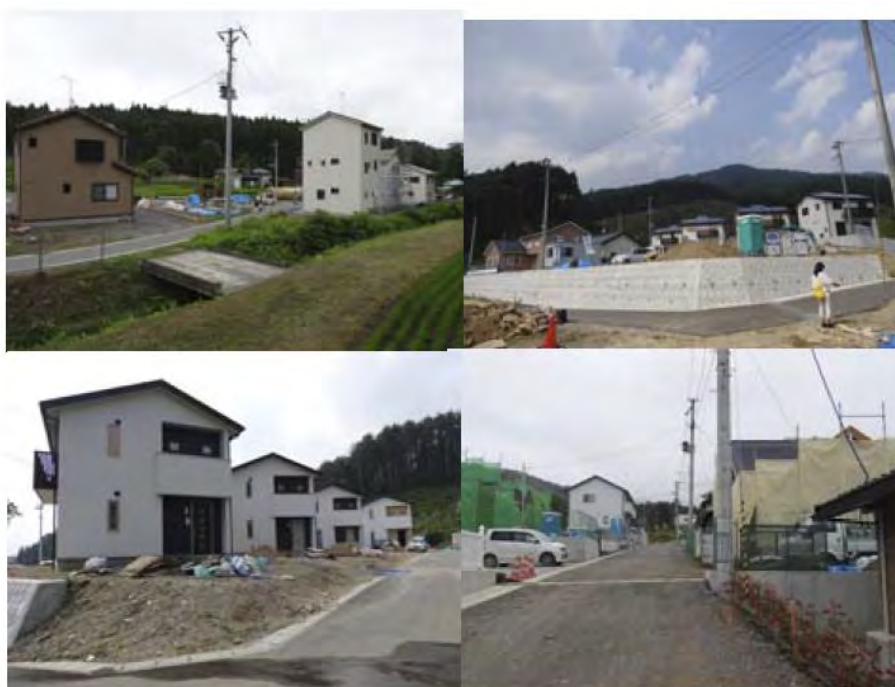
写真 5.2.2 陸前高田市都市計画区域外の非住居系土地利用における宅地造成と新規着工建物（2013年8月）
