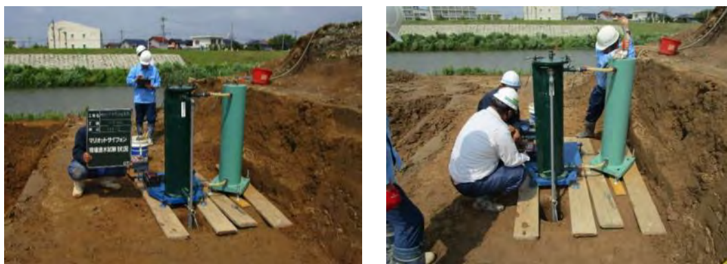
図 4.3.61 マリオットサイフォンを用いた締め固めた地盤での現場透水試験
