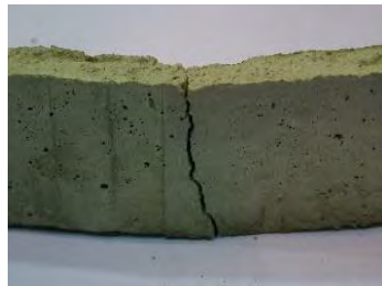
(b) 崩壊部詳細(外周面)
