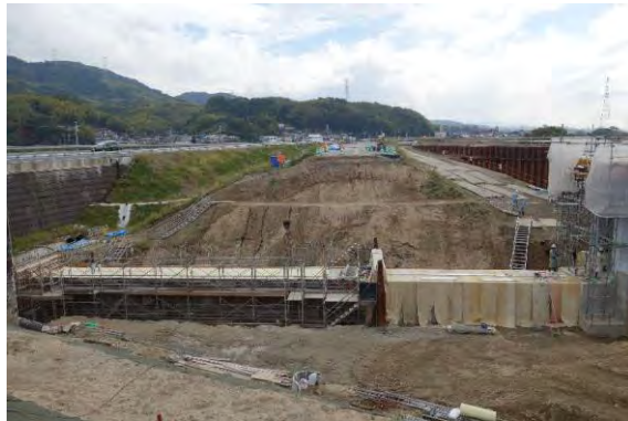
図 4.3.36 開削工事中の堤防
