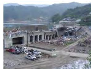
津波により倒壊した防潮堤
