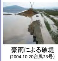
豪雨による破堤 (2004.10.20台風23号)
