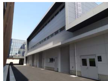
大型実験棟(2013年3月竣工)
