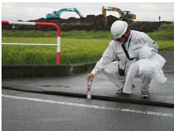
写真 11.11 堤内地に発生した道路の段差
