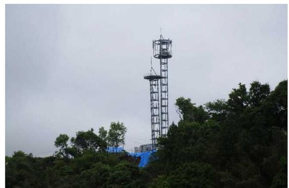
写真 12.18 左岸側の鉄塔の傾斜
