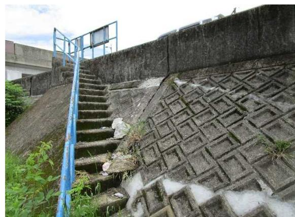
写真 4.12 川表樋門横の損壊したブロック積擁壁
