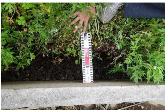
写真 5.17 前面押し出しによる隙間
