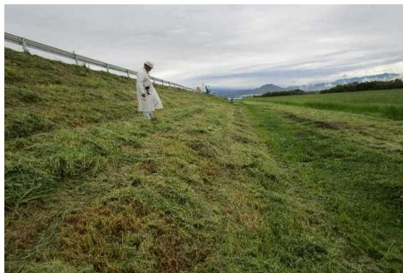
写真 11.4 川表法面の法尻付近のはらみだし
