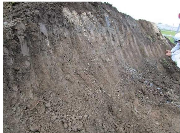
写真 11.8 堤体横断面の様子
