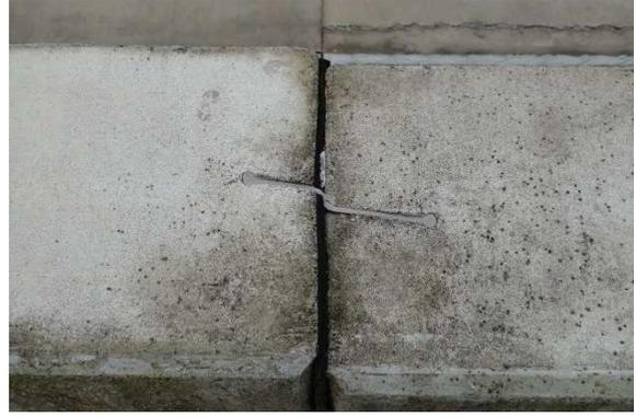
写真 2.14 完成堤防端部の被災状況
