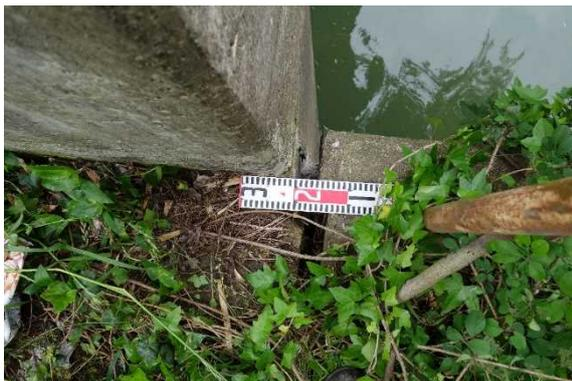
写真 5.23 上流側脚部の損壊
