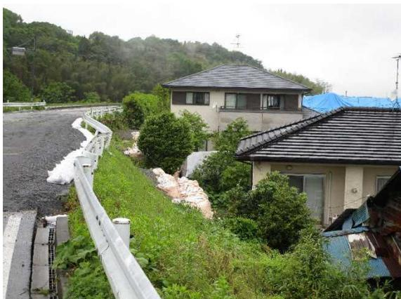
写真 12.3 堤内地の住宅側への法面変状
