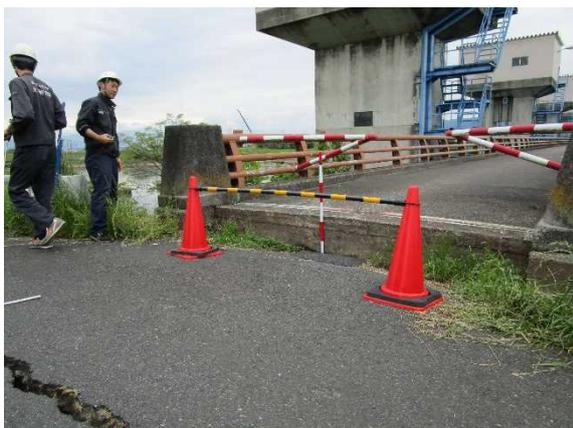
写真 6.3 野田堰右岸側の沈下
