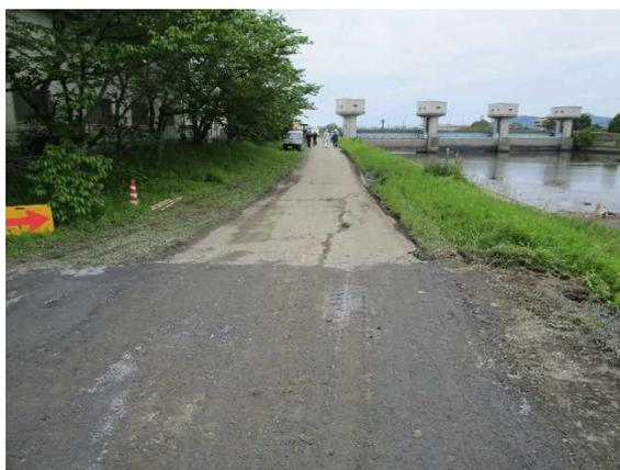
写真 7.4 出張所前の堤防天端の噴砂跡
