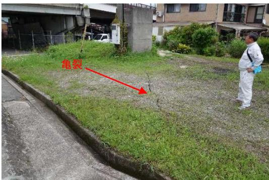
写真4.3 上流側の亀裂（亀裂のみで段差無し）
