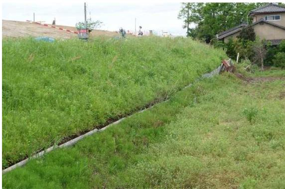
写真 5.13 堤体に押し出されて損壊したドレーン工
