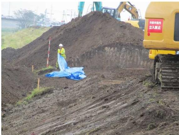
写真 11.7 切り返し工事時に露出した堤体横断面
