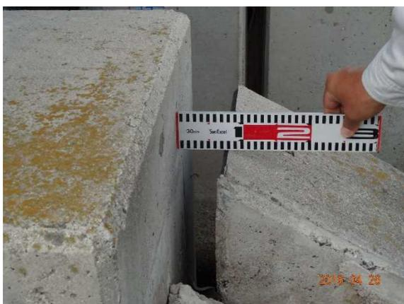
写真 8.3 放流樋管の構造物に発生した隙間
