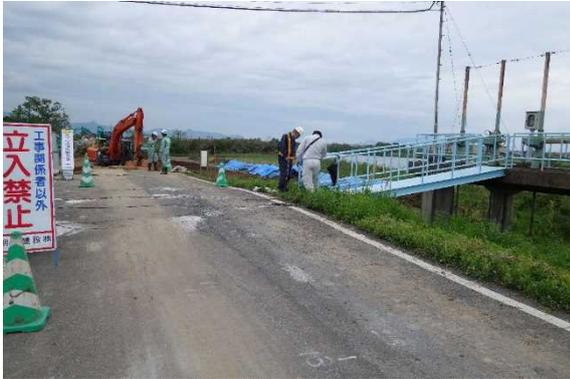
写真 5.25 水門前の天端の亀裂
