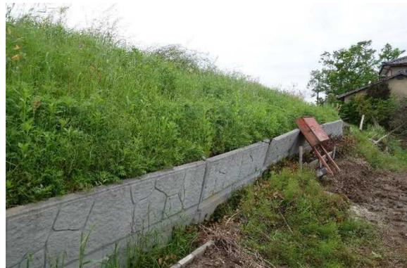
写真 5.14 損壊したドレーン工の近景
