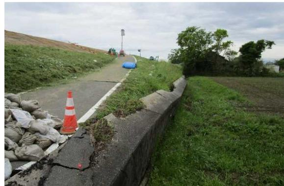
写真 5.10 搬路の土塊に押し出される擁壁
