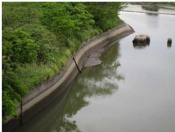
写真 6.2 野田堰近傍右岸側の護岸の変状と噴砂?
