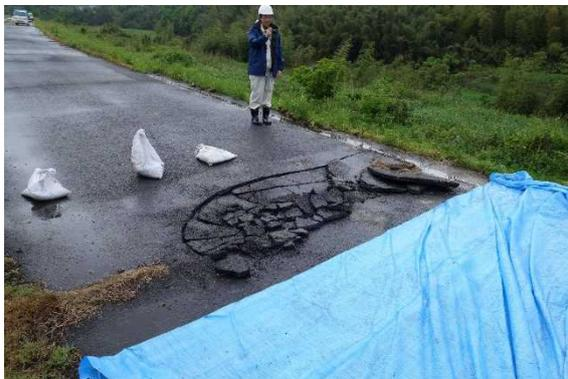
写真 12.15 天端の損傷
