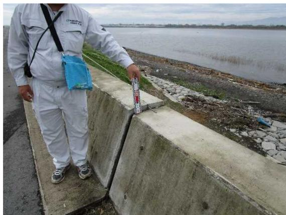
写真 2.12 完成堤防端部の被災状況
