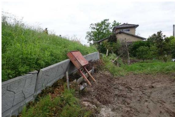
写真 5.15 堤体法尻に押し上げられるドレーン工
