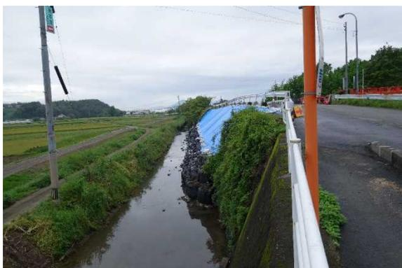
写真 13.1 石積み擁壁が崩壊した法面の応急復旧状況
