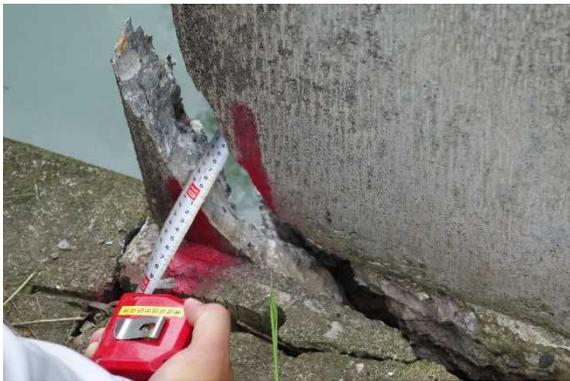
写真 5.21 下流側脚部の損壊
