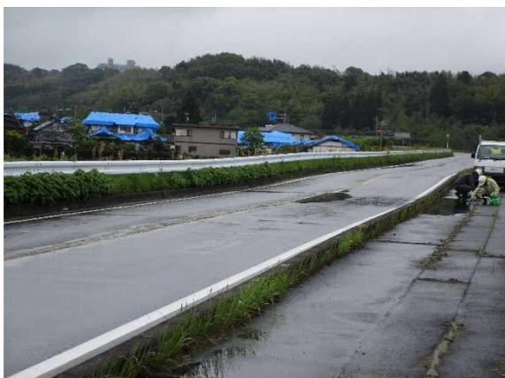
写真 12.5 天端道路の沈下やねじれによる波打ち
