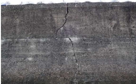
写真 2.7 未補修の亀裂
