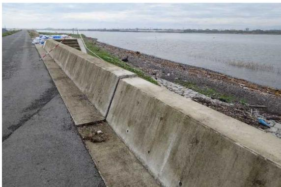
写真 2.11 完成堤防端部の被災状況
