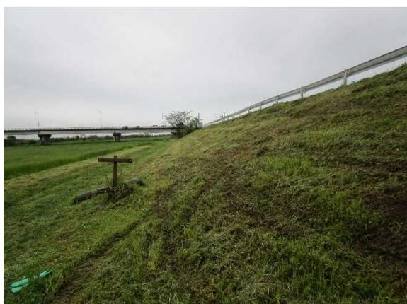
写真 11.5 川表法面の法尻付近のはらみだし
