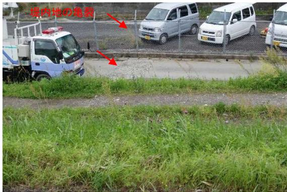
写真 5.27 排水機場前まで続く堤内地の亀裂
