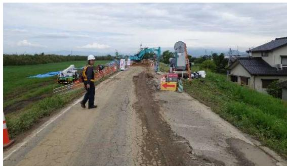
写真 5.2 堤防天端の縦断亀裂
