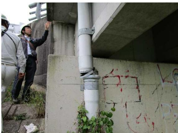
写真 10.5 水神橋の橋桁の水平方向のズレ
