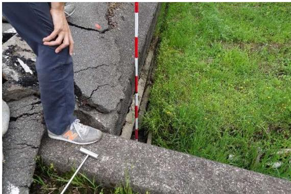
写真 5.11 ブロック積擁壁下流端の状況
