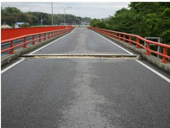
写真 13.9 乙女橋の橋桁の段差
