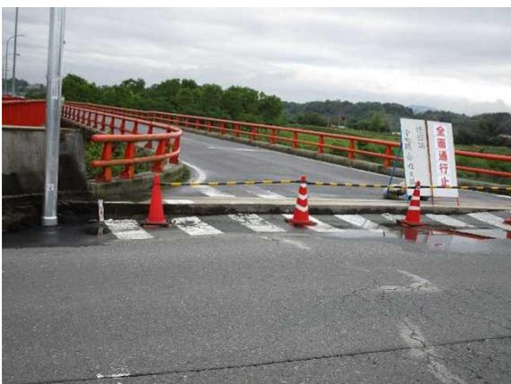
写真 13.11 乙女橋の右岸側の沈下
