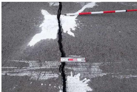
写真 8.6 樋管直上の堤防天端の亀裂
