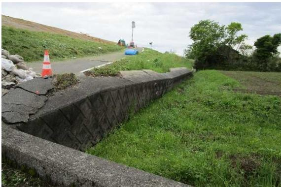
写真 5.9 搬路裾のブロック積擁壁の損壊
