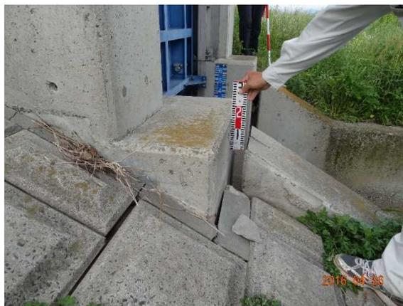
写真 8.2 放流樋管の構造物に発生した隙間
