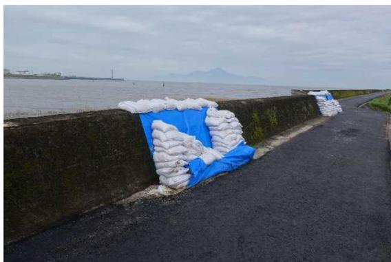
写真 2.8 亀裂発生部の裏側のシート養生の状況
