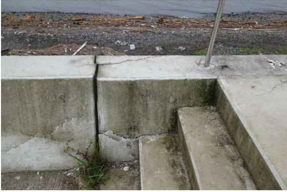
写真 2.13 完成堤防端部の被災状況
