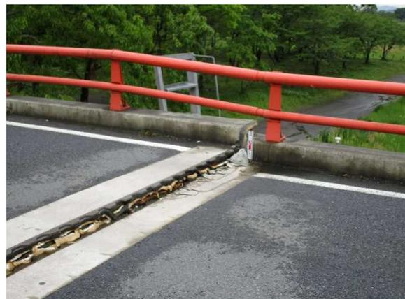
写真 13.10 乙女橋の橋桁の段差
