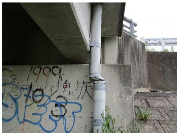
写真 10.6 水神橋の橋桁の水平方向のズレ
