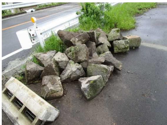
写真 12.4 撤去した石積み擁壁の一部?
