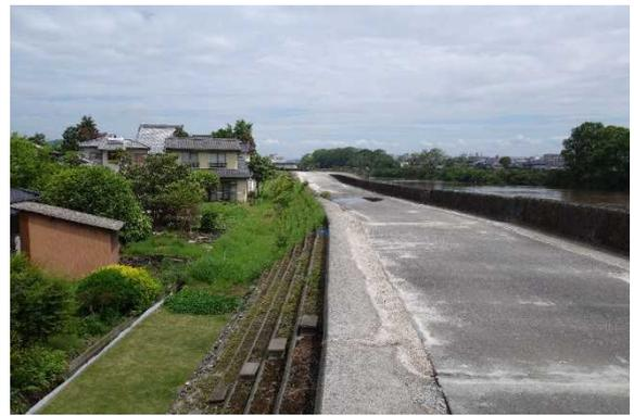
写真 3.2 天端川裏側の沈下
