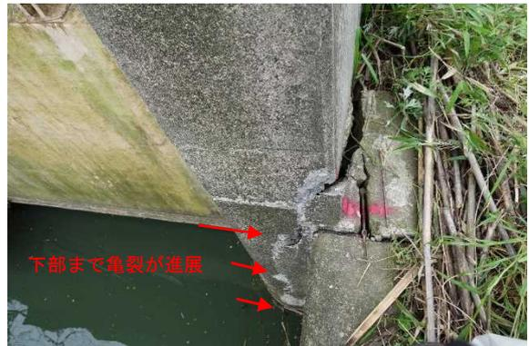
写真 5.22 下流側脚部の損壊
