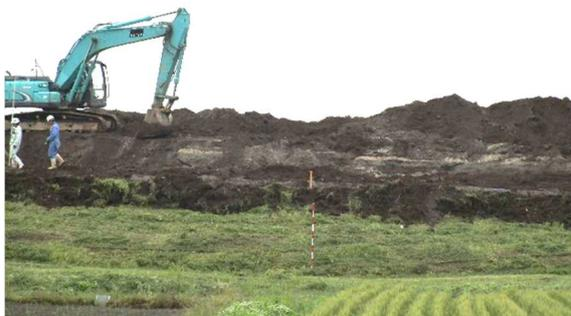
写真 11.9 切り返し工事時に露出した堤体縦断面
