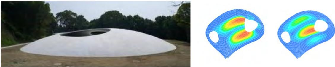
図 2.3.8 検討対象と 1 次振動モード、2 次振動モード
