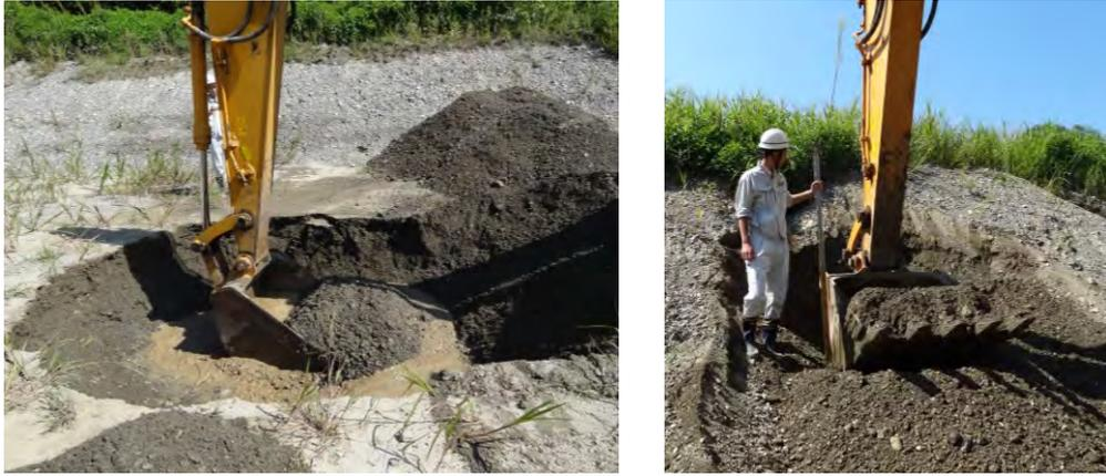
写真 5.2 液状化が懸念される砂礫地盤の採取状況（四国 N 川）
